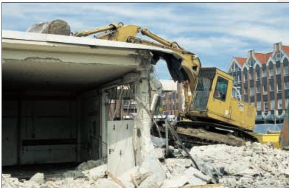
Abbrucharbeiten mit Hydraulikbagger
