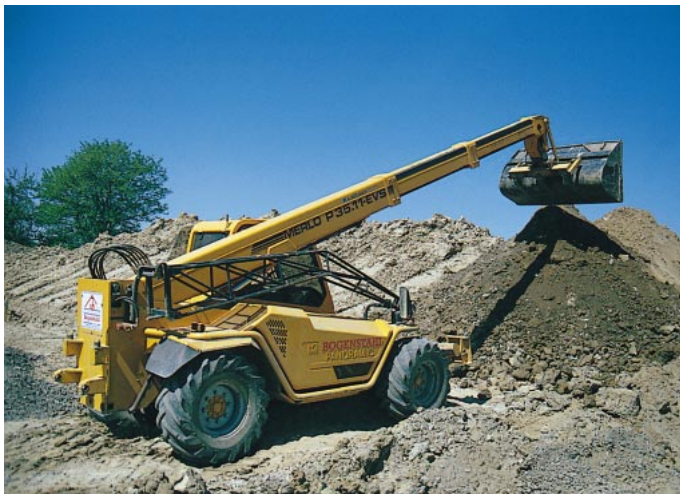
Abb. 1: Teleskopmaschine mit Ladeschaufel bei Erdarbeiten
