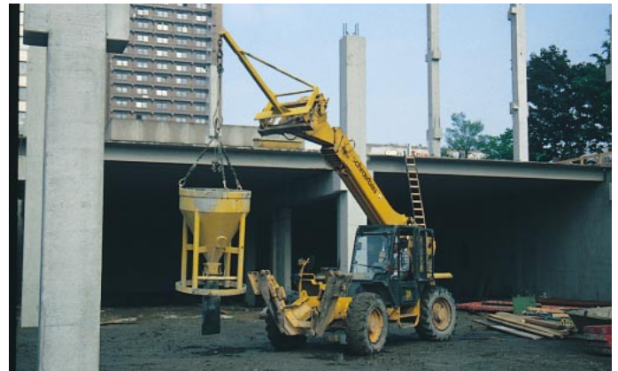
Abb. 12: Ausführung von Betonierarbeiten mit Kranausleger und Betonkübel
