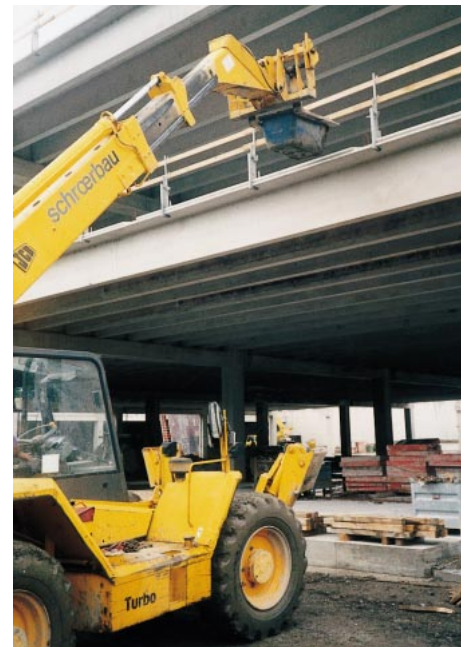
Abb. 2: Teleskopmaschine mit Gabelausrüstung bei der Baustellenbeschickung
