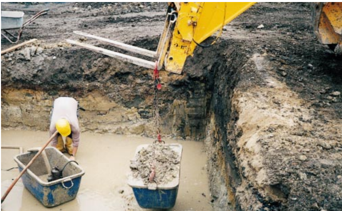
Abb. 10: Unsachgemäßes auf Gabelzinken aufgelegtes Anschlagmittel und überladener Kübel sind eine Gefahr für Beschäftigte
