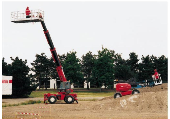
Abb. 4: Teleskopmaschinen in unterschiedlichen Größen für Montagearbeiten
