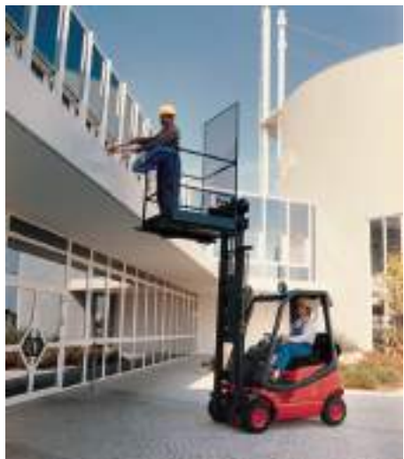
Bild 2: Einsatz von Arbeitsbühne
